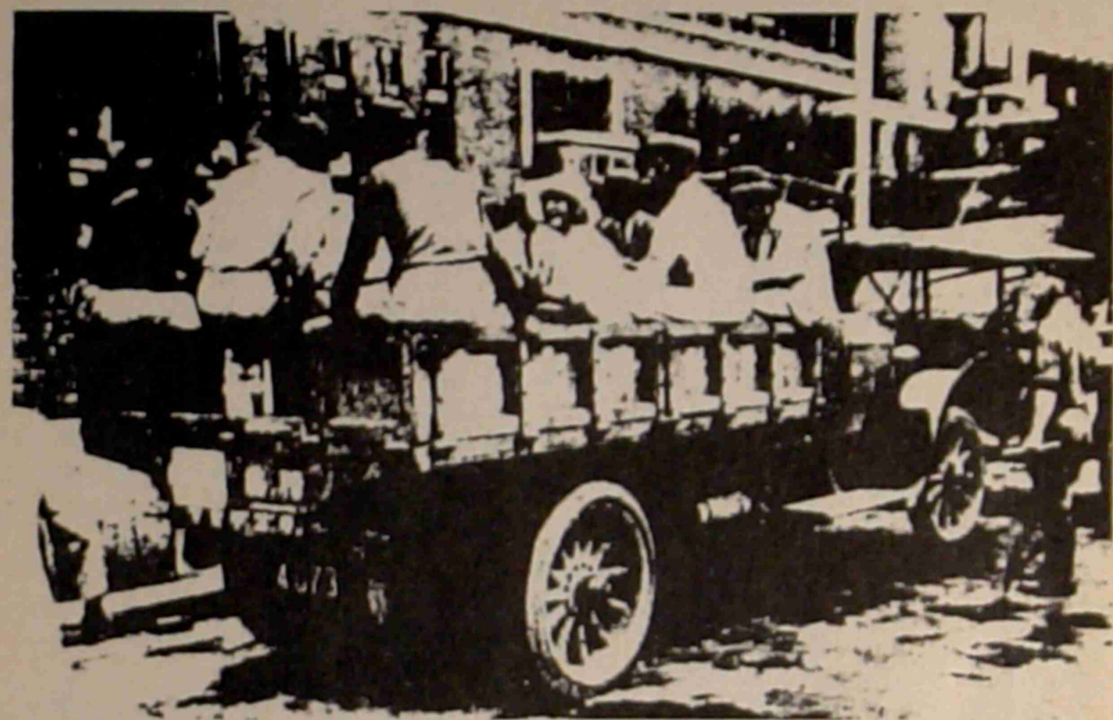
関東大震災で在住外国人の救出にあたる建設業者
