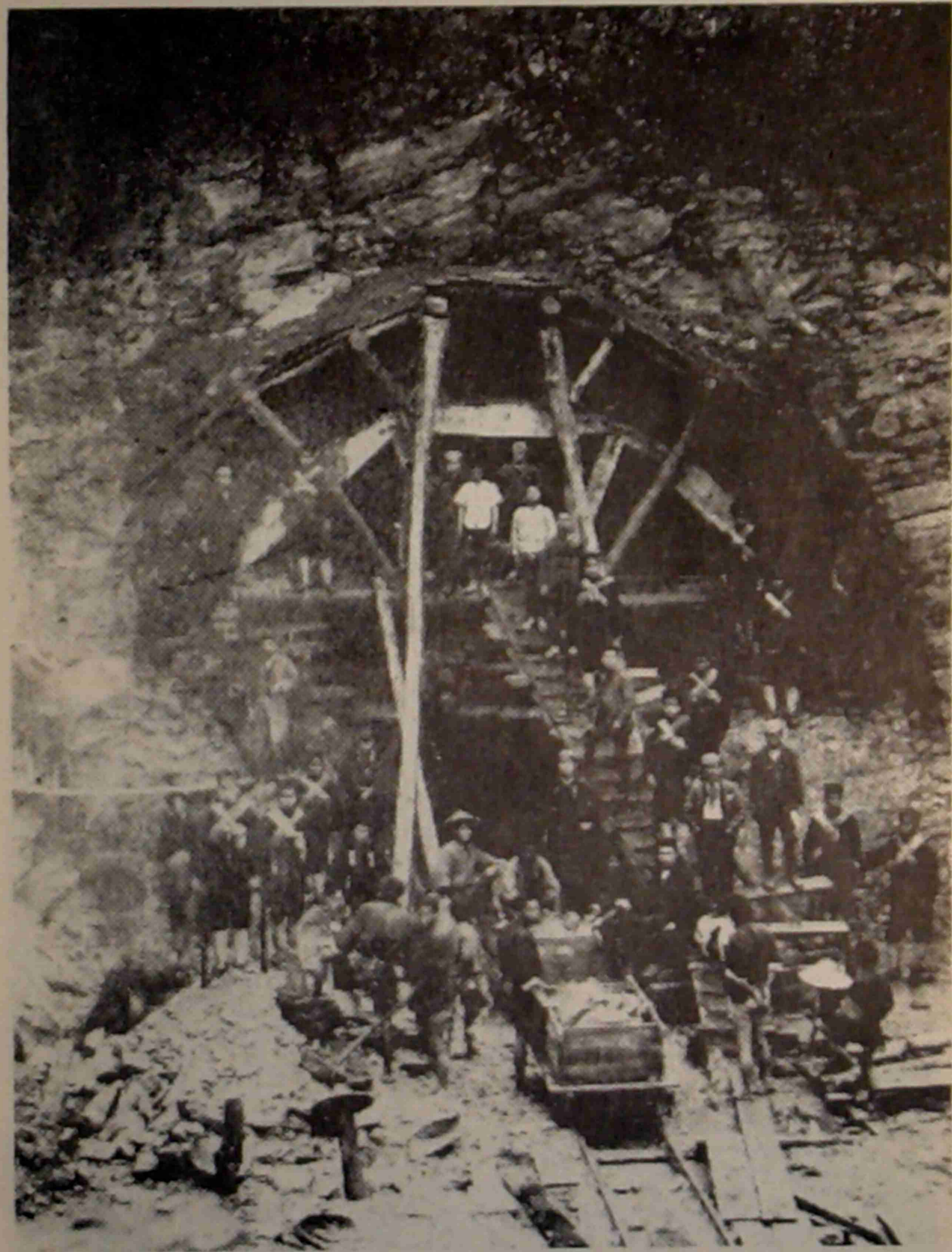
丹那トンネル現場（大正7年）
